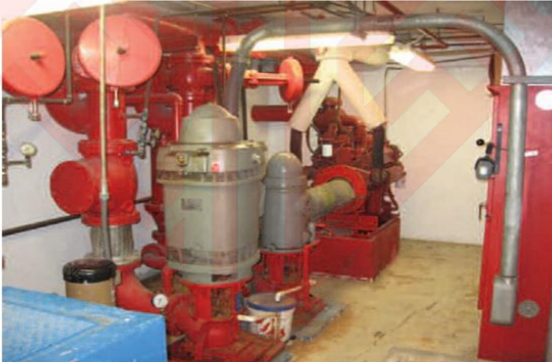
الشكل 7-10/4: مضخات إطفاء حريق فوق سقف خزان خرساني يقع تحت مستوى الارضية [9]
