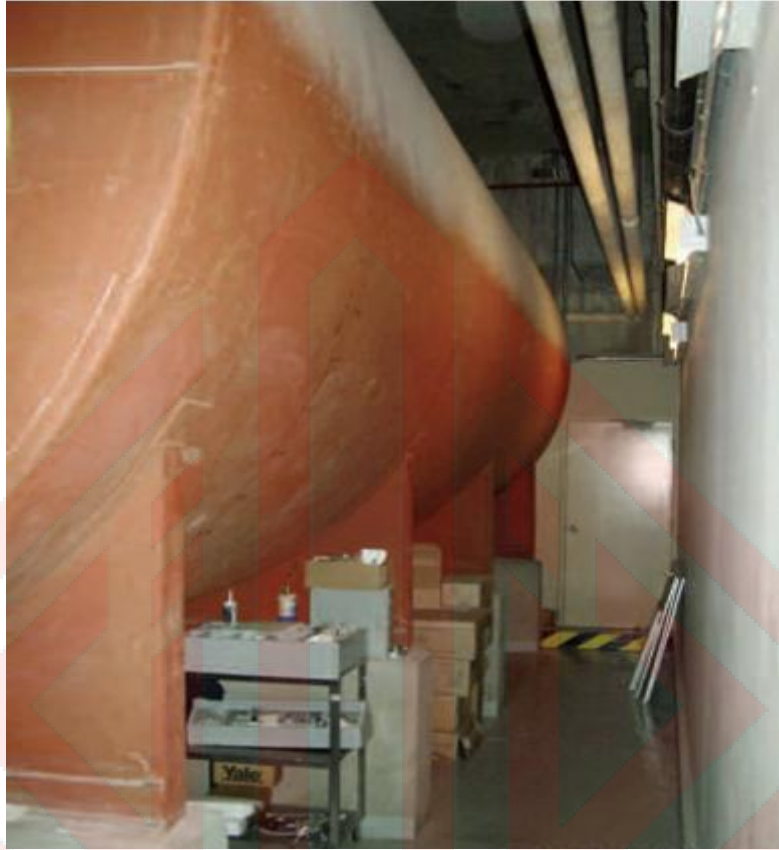
الشكل 7-10/3: خزان فولاذي ملحوم في اعلى طابق في مبنى شاهق [9]
